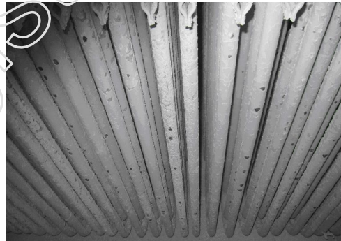
图6 低温段迎风面粘结积灰
