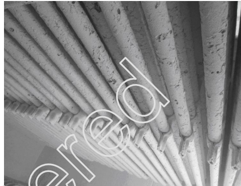
图4 高温段迎风面的板结积灰
